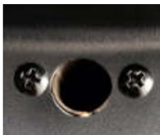
Inspektionsöffnung - für die Sichtkontrolle der Flamme des Booster-Brenners.
